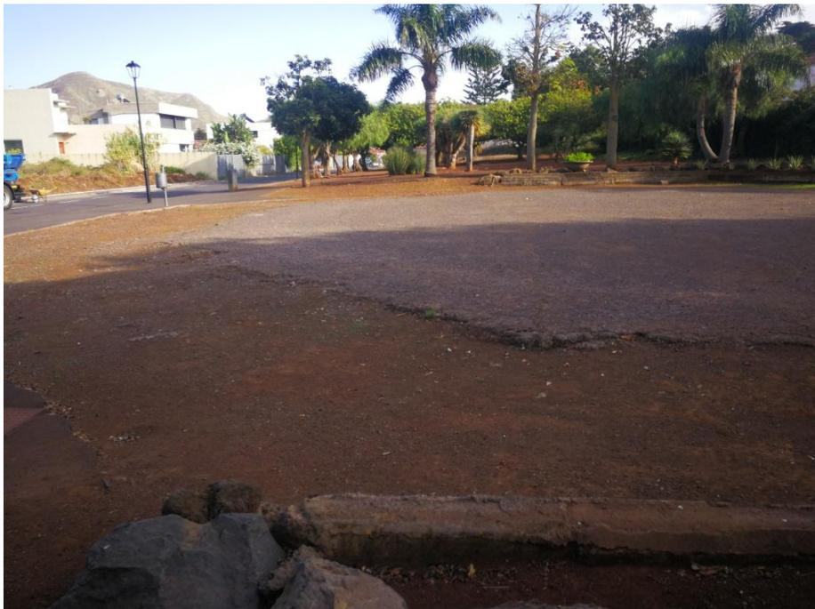
*Concretamente, se observa que en la parte central del parque está deteriorada, el asfalto ha desaparecido en los exteriores y presenta varios desniveles.*
