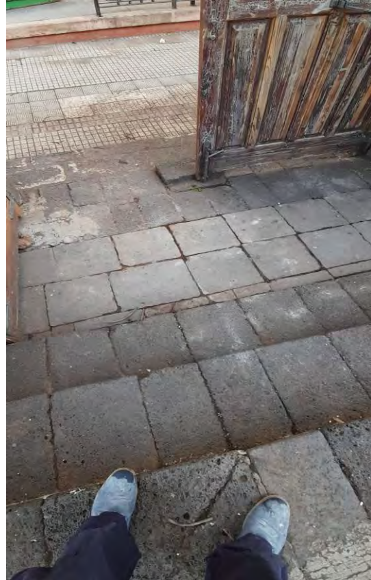
Rebaje de la piedra de la entrada, pudiéndose abrir ahora la puerta completamente, ya que antes habría en un ángulo de unos 30 – 40°.
