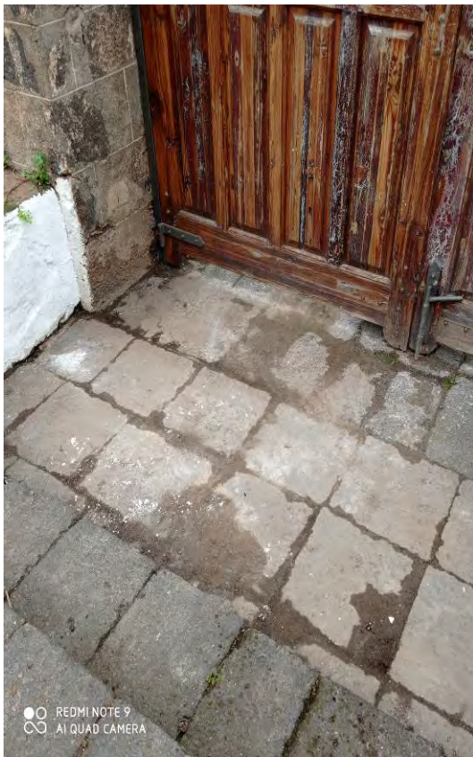
Rebaje de la piedra de la entrada, pudiéndose abrir ahora la puerta completamente, ya que antes habría en un ángulo de unos 30 – 40°.
