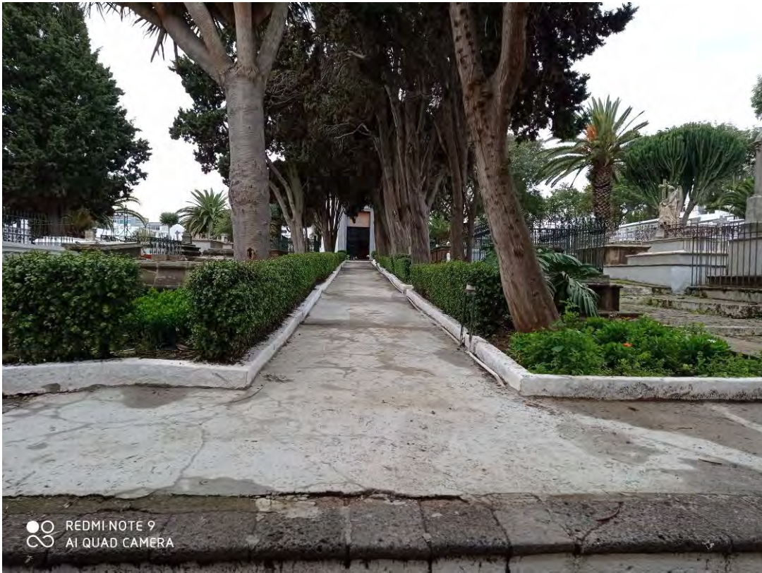
Situación actual de dicho pasillo, habiéndose allanado la superficie elevada.
