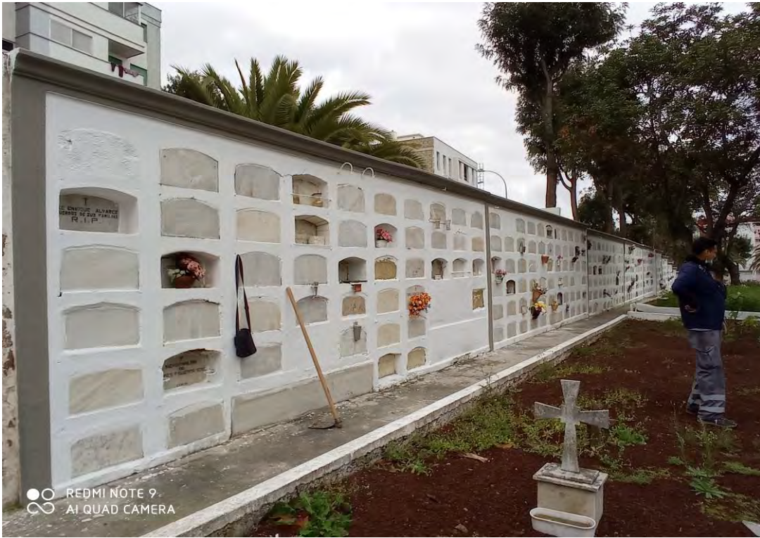
Lijado y pintado de paredes, muros e interlineales de las lápidas.
