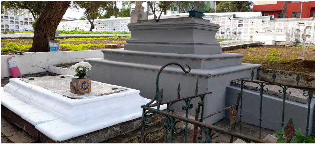
Mejora de partes estructurales externas de algunos panteones.
