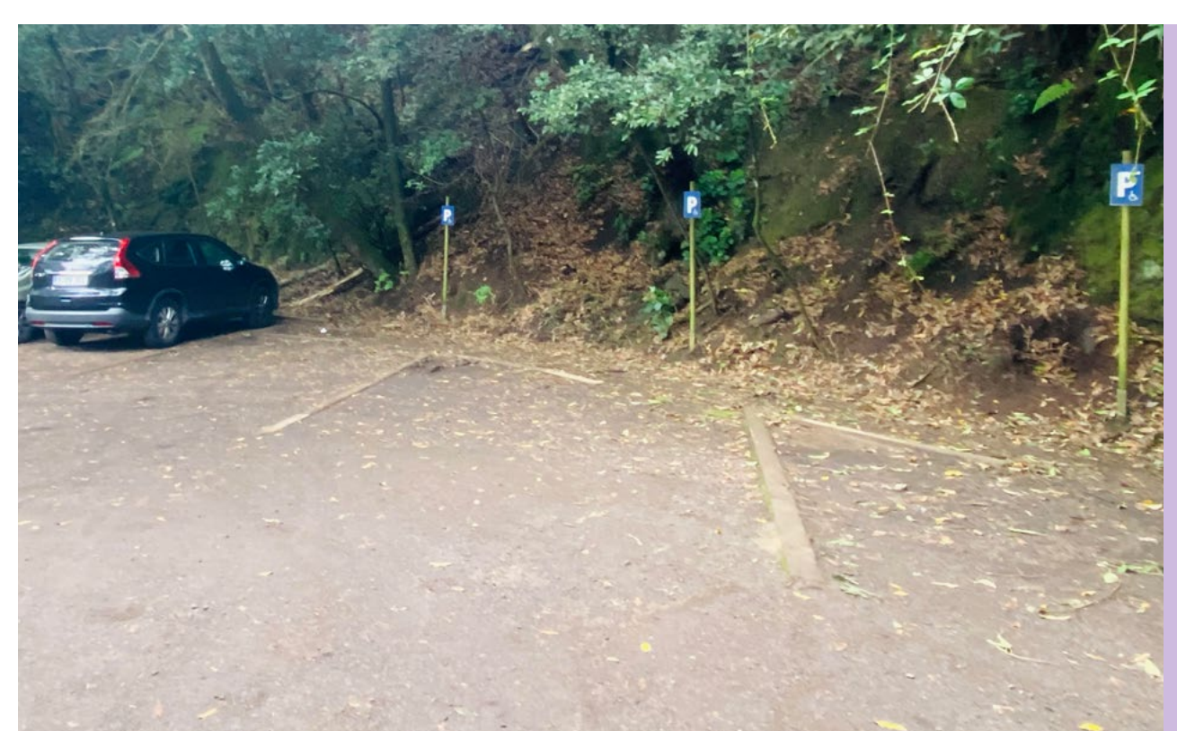
Plazas reservadas PMR
