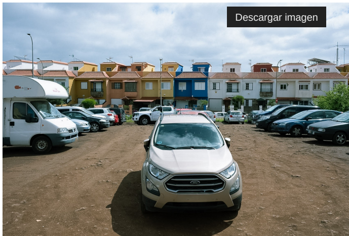
Acondicionamiento y asfaltado
