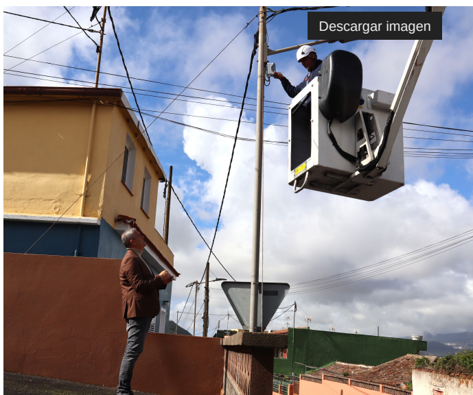
Revisión y reparación
