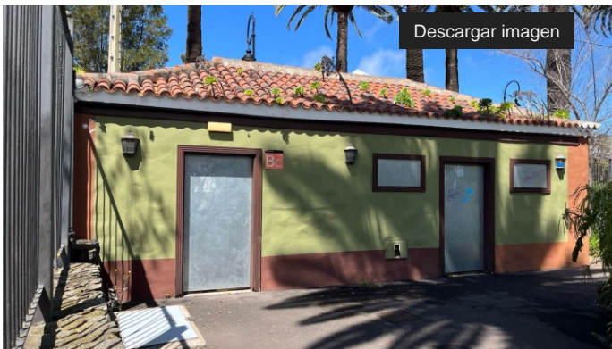
CAFETERIA LA CONSTITUCION
