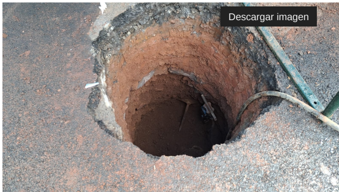
Obras del pozo absorbente
